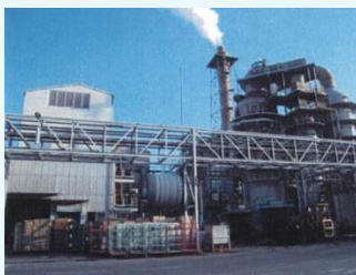
焼却処理施設
