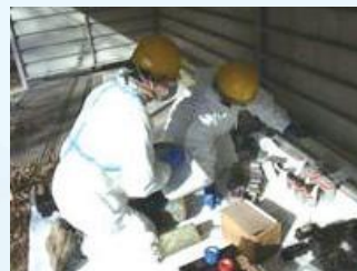
蛍光灯用安定器の銘板調査の状況
