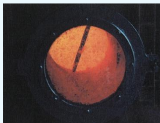
焼却処理施設炉内状況
