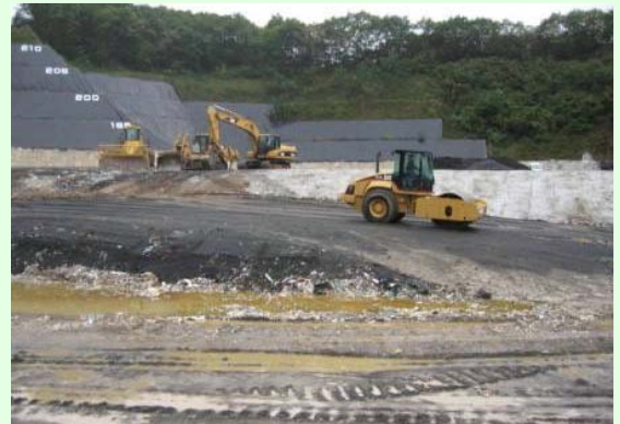
安定型処分場での作業
