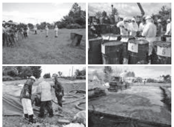
図4 行政代執行の様子 （左上：実施宣言の様子 右上：内容物調査 左下：廃油吸引作業 右下：完了後の様子）
