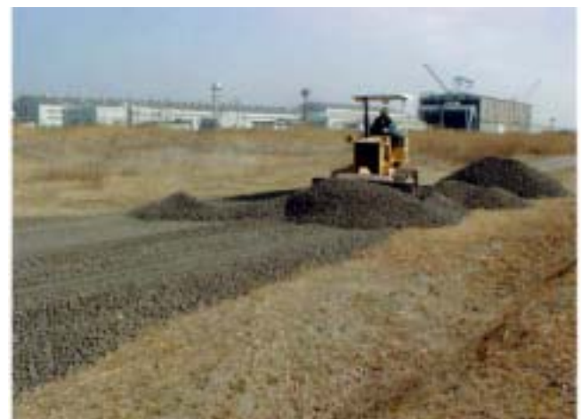
ポリナイトを下層路盤材に（敷均し状況）
