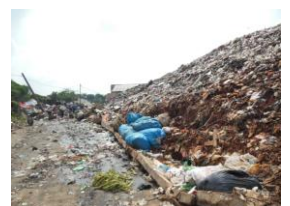
図(5) 生ごみ等の水分や降雨、その他崩壊要因による廃棄物層内でのすべり
