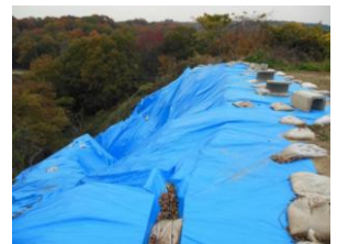
図(4) 廃棄物層内への水の集中的な浸透に起因したすべり
