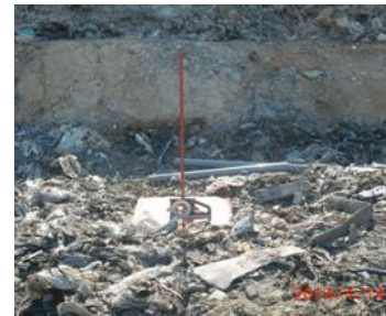
図 37 廃棄物地盤上への沈下板の設置
