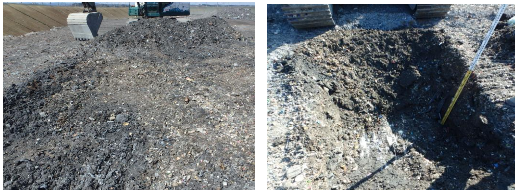
図 3 ② ふるい下等で 10cm 以下のプラスチック等を含む地盤 (左; 表層 右; 試掘断面)
