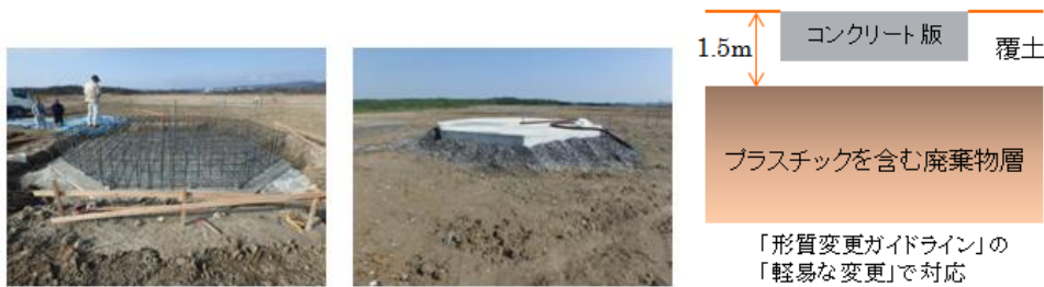
図 16 廃棄物地盤上に設置したコンクリート基礎（径 7m、厚さ 1m）
