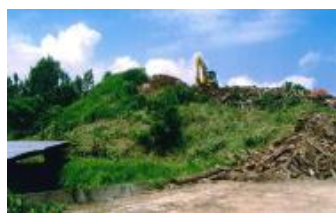
1)大型がれき・角材等現場
