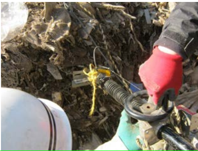
写真2 現場引抜試験
