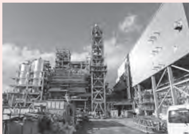
建設中の焼却施設
