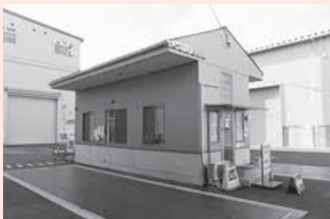
新焼却炉増設に伴い、計量棟も2レーンに変更
