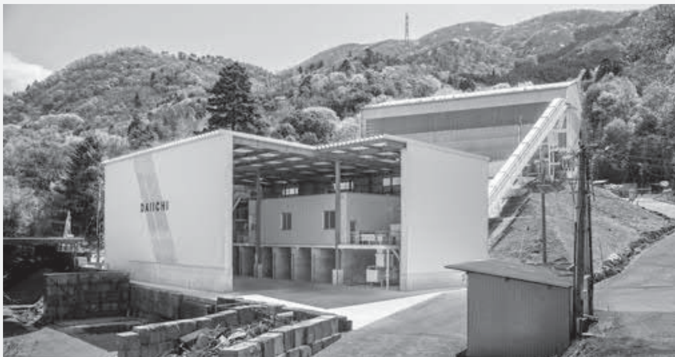
新選別プラント外観
