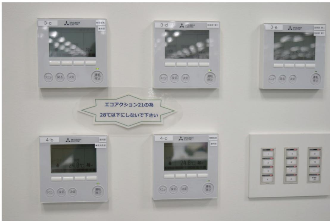
設定温度の目安が表示されている空調操作盤
