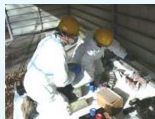
蛍光灯用安定器の銘板調査の状況
