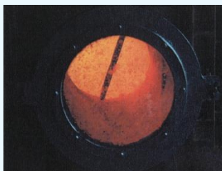
焼却処理施設炉内状況
