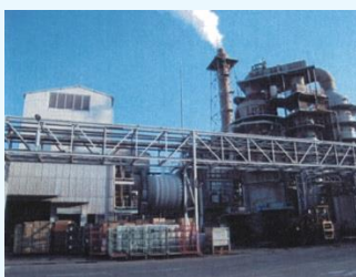
焼却処理施設
