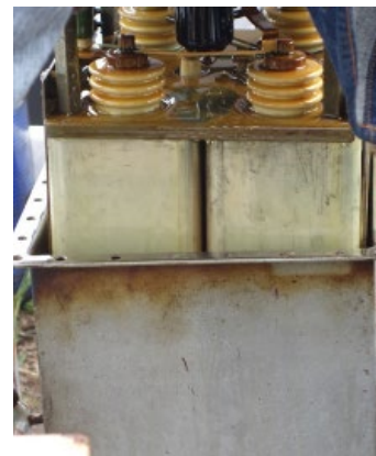
絶縁油槽に漬け込まれた低圧コンデンサー
