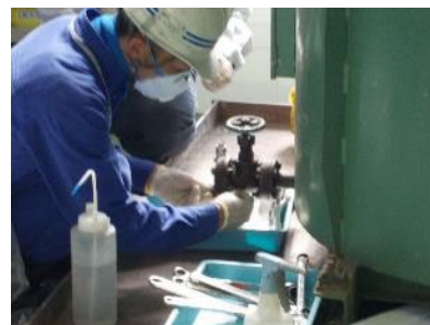
採取口付きの変圧器からの絶縁油の採取
