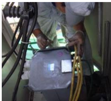
採取口がない変圧器からの絶縁油の採取
