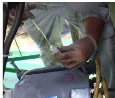
採取口がない変圧器からの絶縁油の採取
