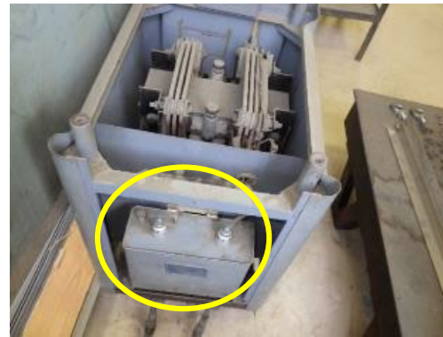
電気溶接機に設置された低圧コンデンサー
