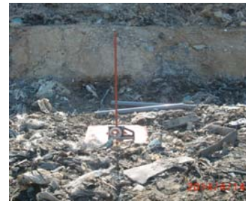
図 37 廃棄物地盤上への沈下板の設置
