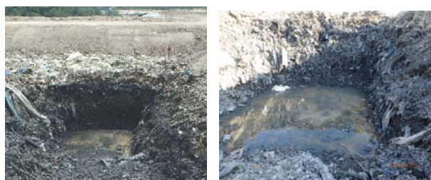
図 12 内部水位より 25m 高い地点での試掘後 6 時間後の湛水（中部地方の安定型処分場） （左：試掘時 右：試掘 6 時間後の湛水）
