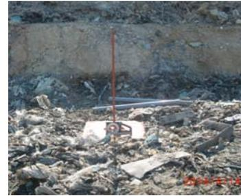
図 37 廃棄物地盤上への沈下板の設置
