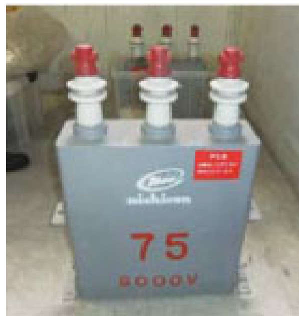
電力用コンデンサー
