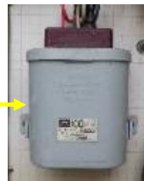
分電盤に設置された低圧コンデンサー
