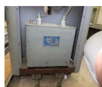
電気溶接機の側面に取り付けられた低圧コンデンサー
