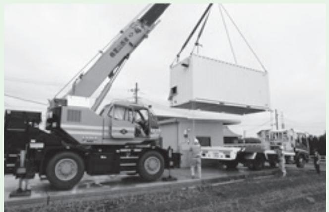
コンテナ納品のような。据付後、配管接続や試運転、制御設定等は2日間で可能
