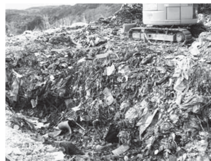
図3 掘削現場の状況 (左：掘削地点(10m×10m、深さ3m) 右：掘削された廃棄物)
