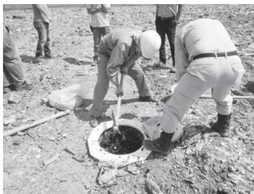
写真9 現場密度試験
