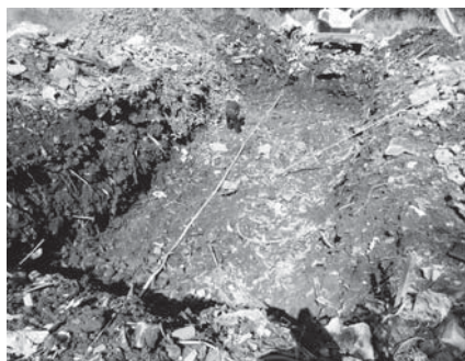
図3 掘削現場の状況 (左：掘削地点(10m×10m、深さ3m) 右：掘削された廃棄物)
