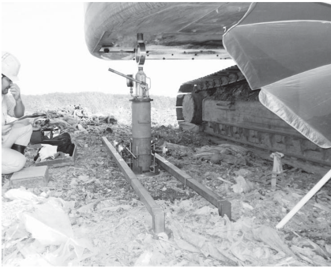
写真3 平板載荷試験
