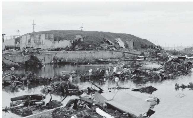
東日本大震災後の現場
