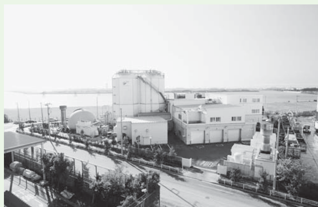
写真3 バイオエナジー(株)城南島工場
