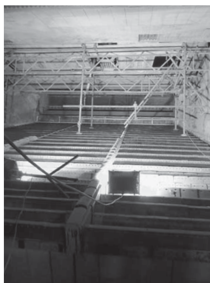
写真3 Cheneviers廃棄物処理センターのストーカー炉
