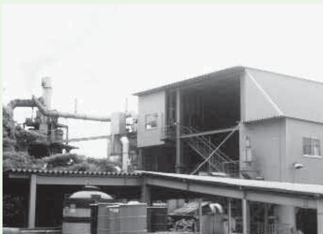
日進プラント〔焼却施設〕
