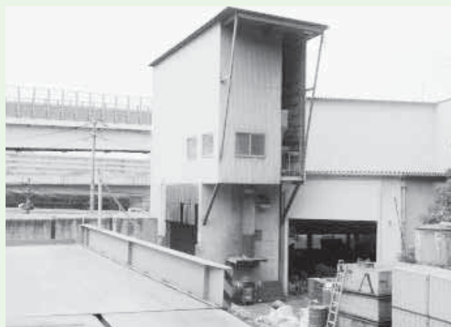
日進プラント〔混練施設〕
