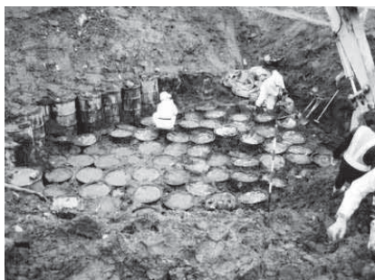
写真 ドラム缶撤去状況
