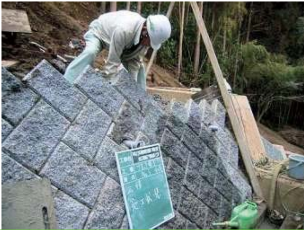
モデル工事(護岸工事)
