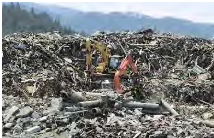
写真 仮置き場での作業状況
