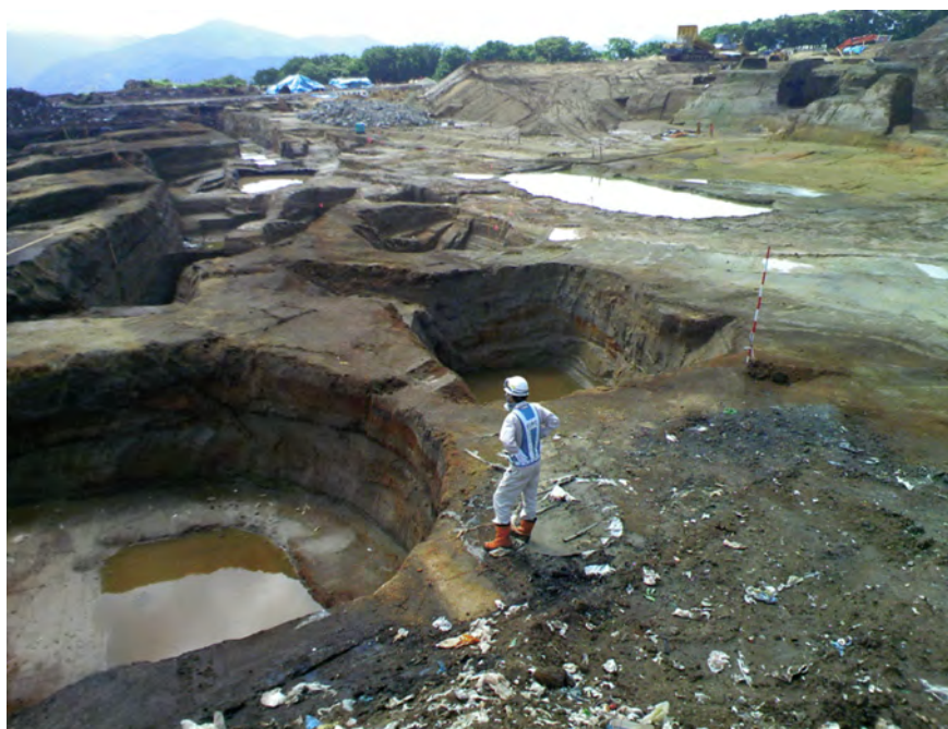
写真 1 露出した地山の状況
