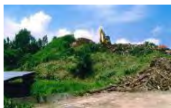
1)大型がれき・角材等現場
