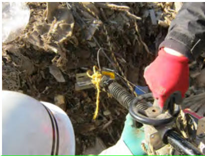
写真2 現場引抜試験
