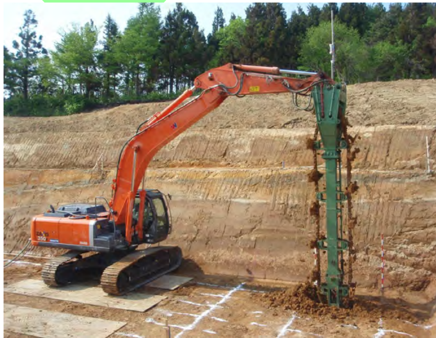
写真3 フェントン工
