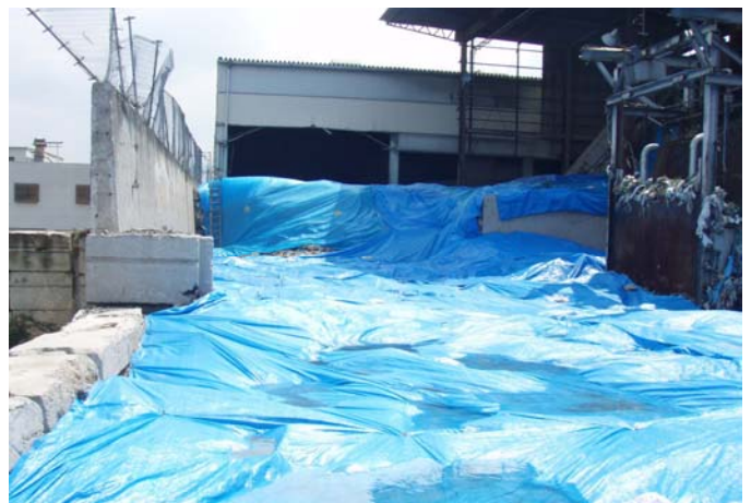
図2 撤去作業終了後、残る廃棄物にシート掛けを施工。現在、複数地点で温度測定を定期的実施
