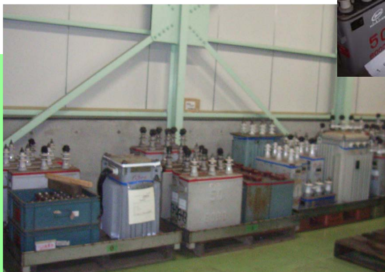
コンデンサ、変圧器の調査、分別の状況
