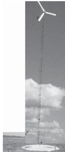
図7 想定した小型風力発電設備  $h=30\text{m}$
