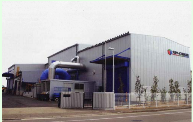
バイオソリッド燃料化施設建屋
