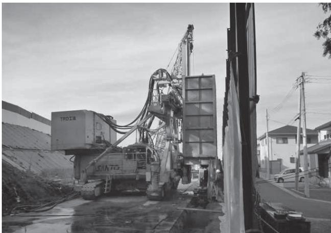
写真3 鉛直遮水壁工施工状況
