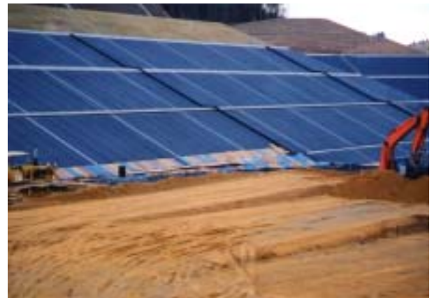
埋立の始まった新処分場、法面下部を廃棄畳で保護するなど丁寧な作業状況が見られる
