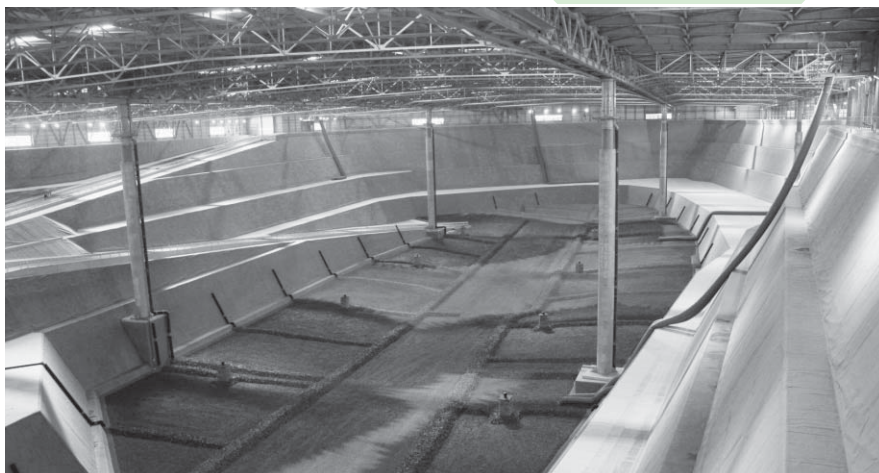
図2 覆蓋施設の内部(埋立地内部)
