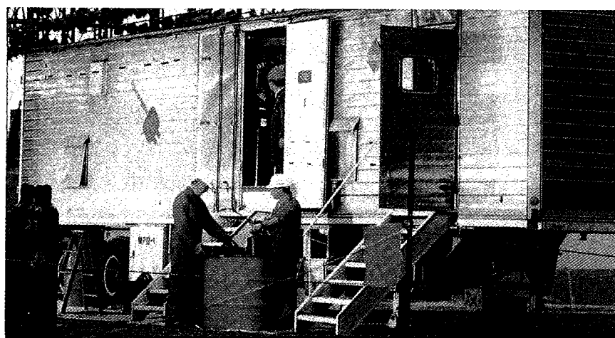
カナダオンタリオハイドロテクノロジーズ社 液体PCBの処理
