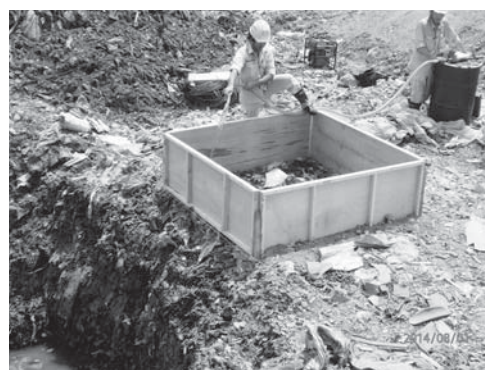
写真1 中部①現場での注水-沈下実験(注水時)
