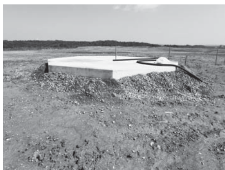
写真5 廃棄物地盤上(覆土上)の コンクリート版の設置状況
