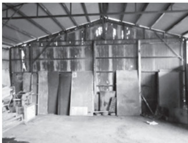
倉庫内 撤去後
