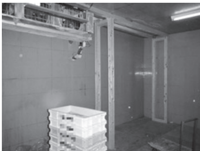
冷凍庫内 撤去後
