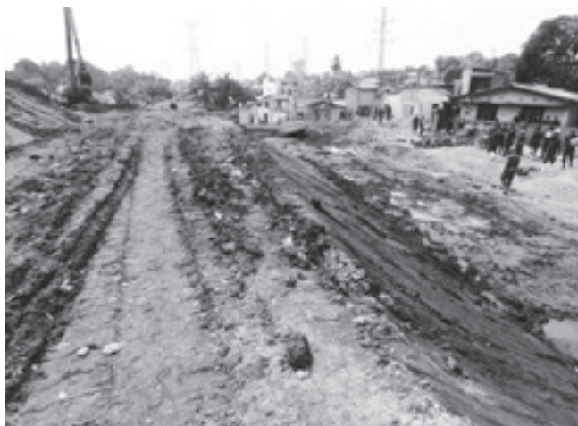
図3 水が浮いている軟弱地盤(斜面下部)
