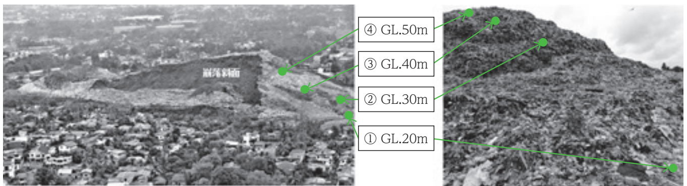
図1 斜面崩壊したミートタムツラ廃棄物処分場と試験場所 Left photo by National Building Research Organization (2017年4月)
