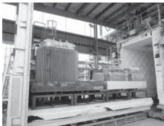
東京鐵鋼（株）の固定床炉
