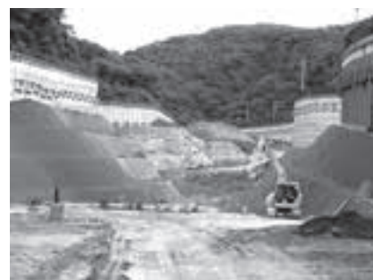
写真3 かながわ環境整備センター
