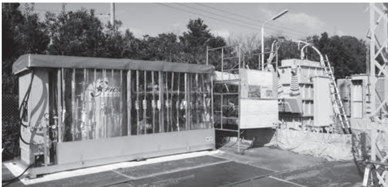
(株)かんでんエンジニアリングの移動式洗浄施設
