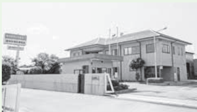
中間処理施設
