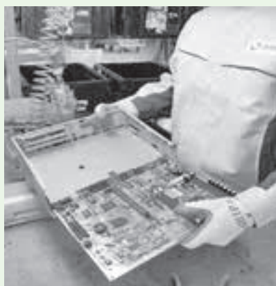
パソコン手作業解体の作業風景
