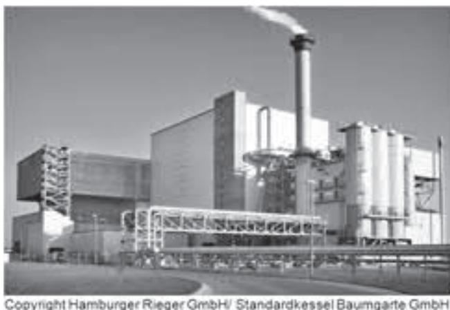
ドイツ東部に位置するシュプレンベルグ市では、廃棄物を産業用エネルギーとして活用する取組みが進められている。本施設は、同市のHamburger Riegar製紙会社により運営され、同市および周辺のRDFプラントから収集された廃棄物を日量約1,000t処理し、最大130t/hの蒸気を発生させ全量隣接する自社の製紙工場へ供給している。これにより、自社工場のプロセス蒸気を賄うことが出来るだけでなく、自家発電設備の蒸気の一部としても活用することが可能となっている。
