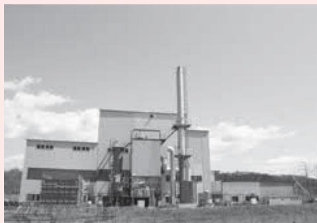
産業廃棄物焼却施設外観
