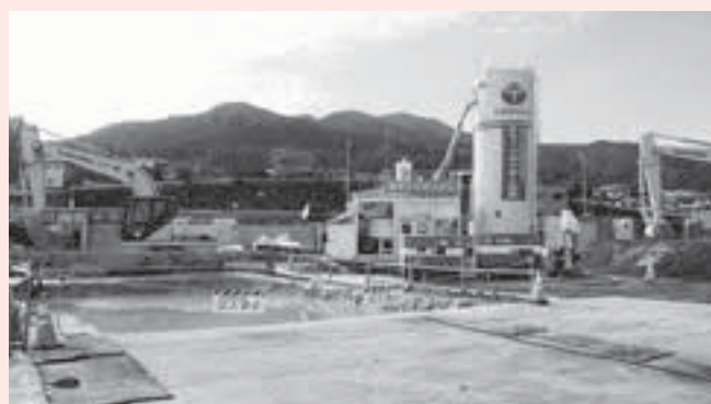
建設汚泥 移動式中間処理
