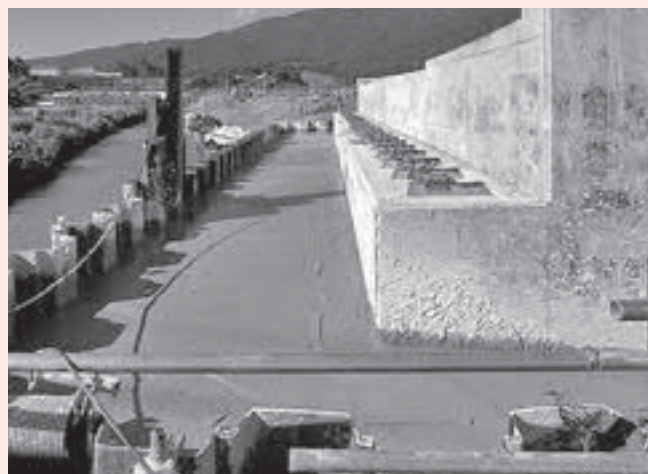
打設後(仕上がり)
