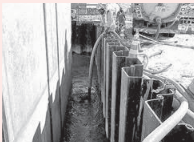
流動化処理土 打設状況
